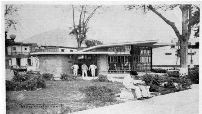
Figura N° 2: Estación Bibliotecaria «Malecón Rímac». Fuente: Gaceta Bibliotecaria del Perú , N° 1, p. 5
